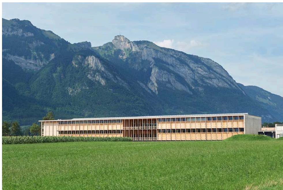
Il sedime dell'Istituto agrario si trova ai margini del villaggio di Salez, nel bel mezzo della vasta Valle del Reno. L'edificio scolastico è una costruzione in legno a due ali. Tra questa lunga nuova costruzione dalla volumetria imponente e l'officina esistente è stato creato un ampio cortile. Foto: Seraina Wirz
