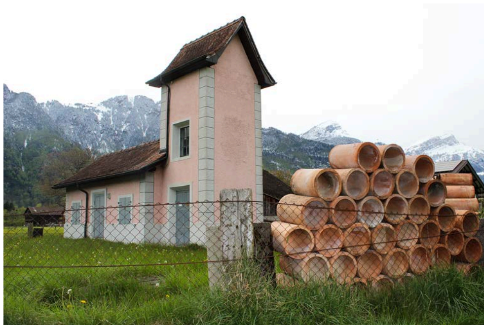
Stazione di pompaggio del consorzio di bonifica con stazione di trasformazione (Foto: MGR)
