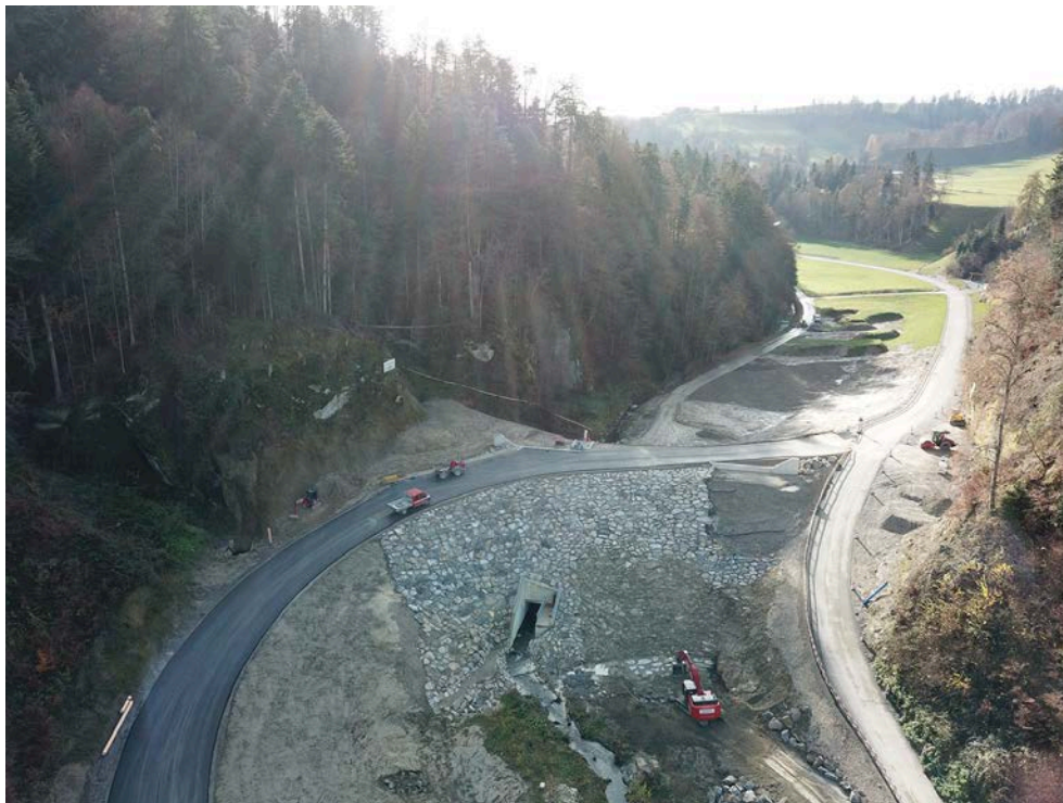
Vista sulla diga per la protezione contro le piene e sul bacino di accumulo nella parte in alto della foto.
