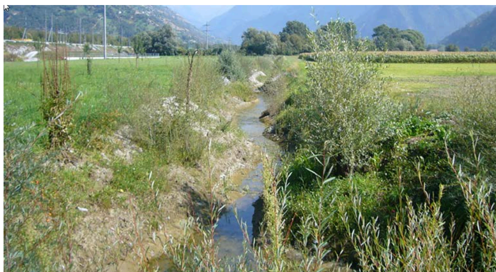
Cours naturel du ruisseau : une des mesures de remplacement dans le cadre de la construction de l'A9
