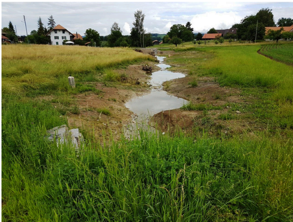
Ripristino dello scorrimento a cielo aperto del Rainbächli (ancora senza vegetazione)
