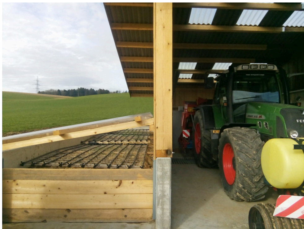
Area di riempimento e piazzale di lavaggio (a destra) dotato d'impianto di evaporazione (Biobed) sotto forma di «silo mobile» (a sinistra), collettore di fanghi e serbatoio per il recupero dell'acqua di risciacquo
