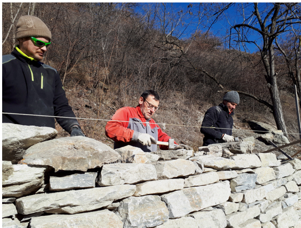
Corso di formazione a Châteauneuf. Martin Lutz insegna sul campo i gesti corretti per costruire un muro.
