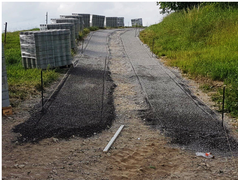
Preparativi per la posa degli elementi grigliati inerbiti. Un profilo negativo del tetto convoglia l'acqua in una canaletta mediana di deflusso.
