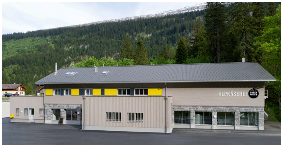
Il nuovo edificio del caseificio alpestre di Urnerboden
