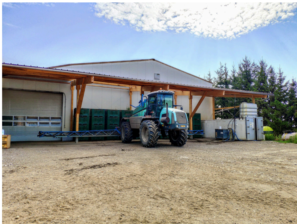
Area di riempimento e piazzale di lavaggio dotato d'impianto di evaporazione (Biobed) in palette, collettore di fanghi sotto l'irroratrice, a destra serbatoio per il recupero dell'acqua di risciacquo.
